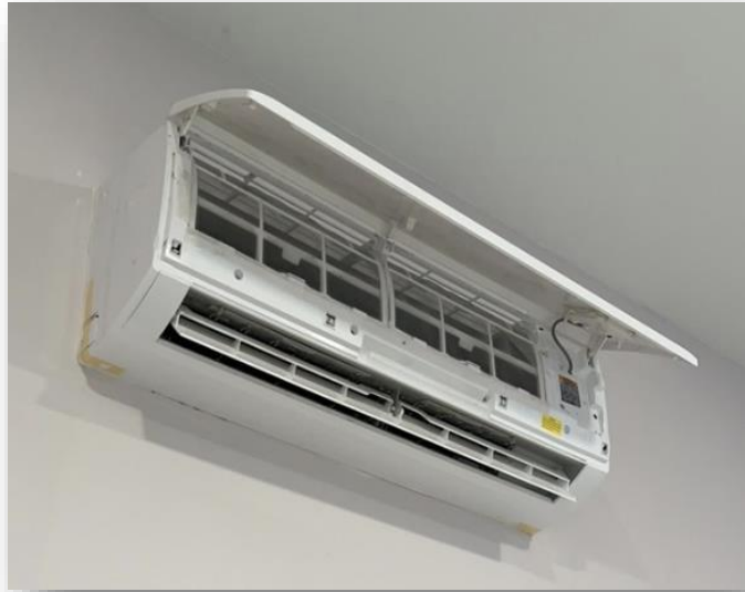
HVAC Mini Split System
